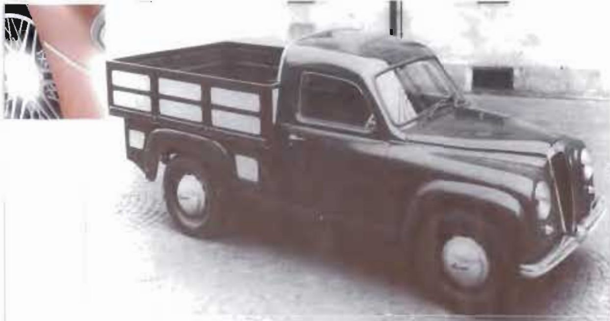
A destra, la Lancia Appia Terza serie furgone carrozzata da Viotti apportando semplici modifiche alla Giardinetta che lo stesso carrozziere realizzava per conto della Lancia. Gli interventi più importanti riguardarono l'eliminazione della seconda fila di sedili e la sostituzione dei finestrini posteriori con pannelli di lamiera innervata sui bordi. A fianco, l'autolettiga Lancia C86 direttamente derivata dal furgone C80.
